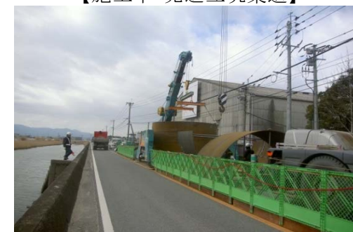
【施工中 発進立坑築造】
