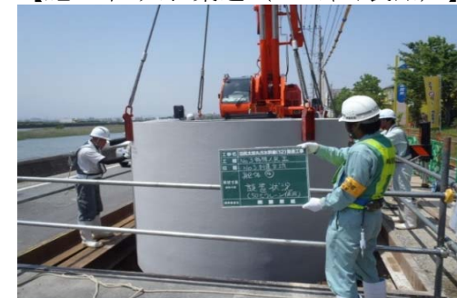
【施工中 人孔築造（プレキャスト製品）】
