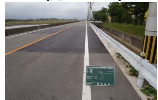
【完成 No. 3 到達部】
