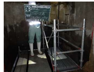
足場工の工夫
