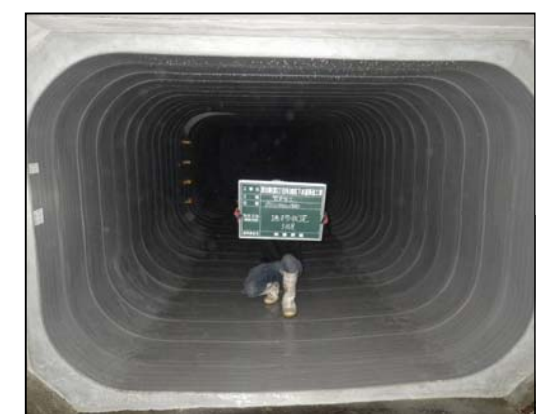
【 「クリアフロー工法」完成 】
